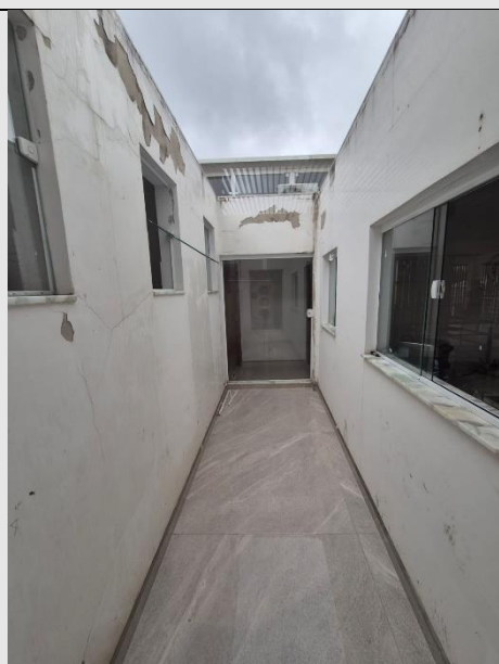
Descrição: Área de Claridade
