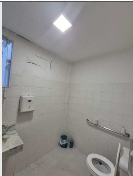
Descrição: WC Acessível (Segundo Pavimento)
