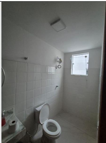
Descrição: WC (Segundo Pavimento)
