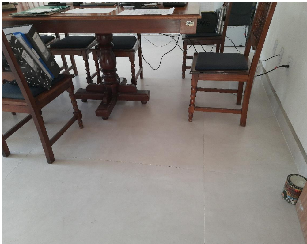
Figura 18 – Aplicação de porcelanato e rodapé no 2º Pavimento.
