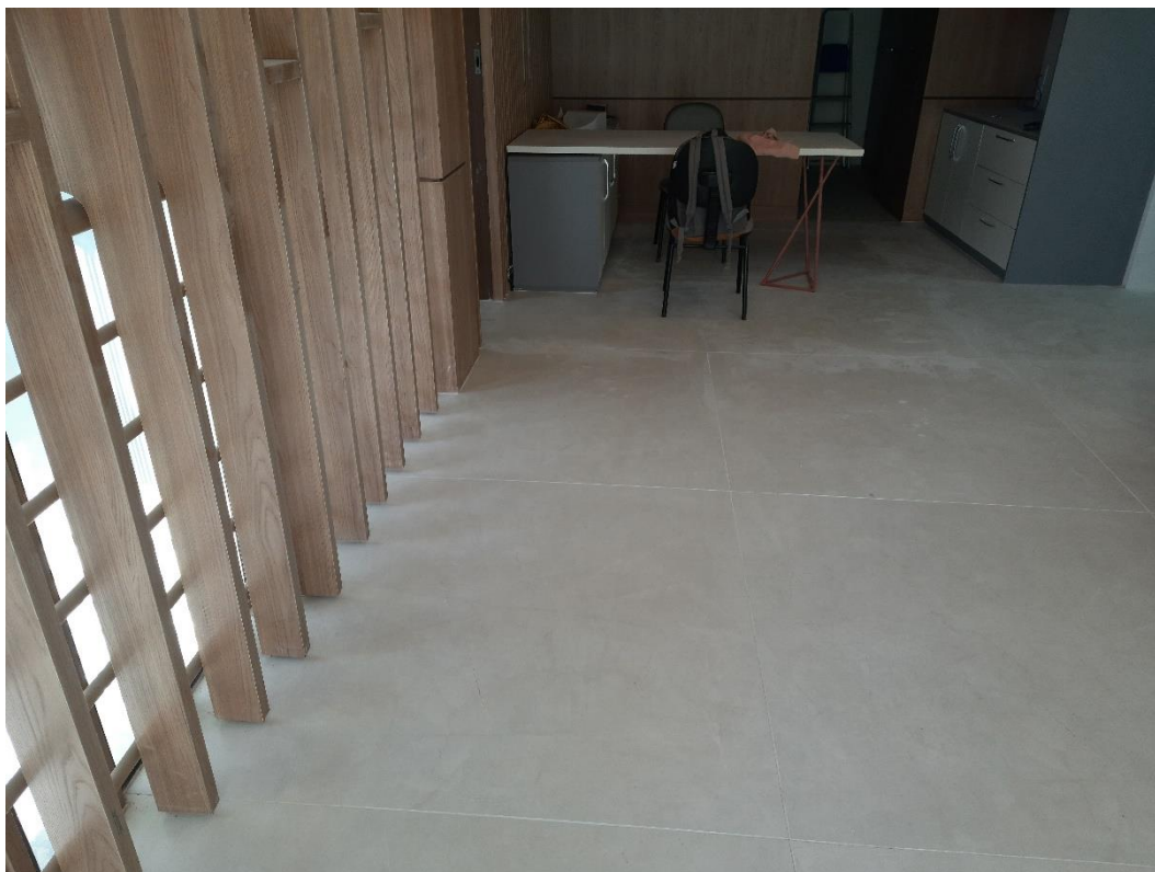
Figura 8 – Aplicação de porcelanato e rodapé no 1º Pavimento.
