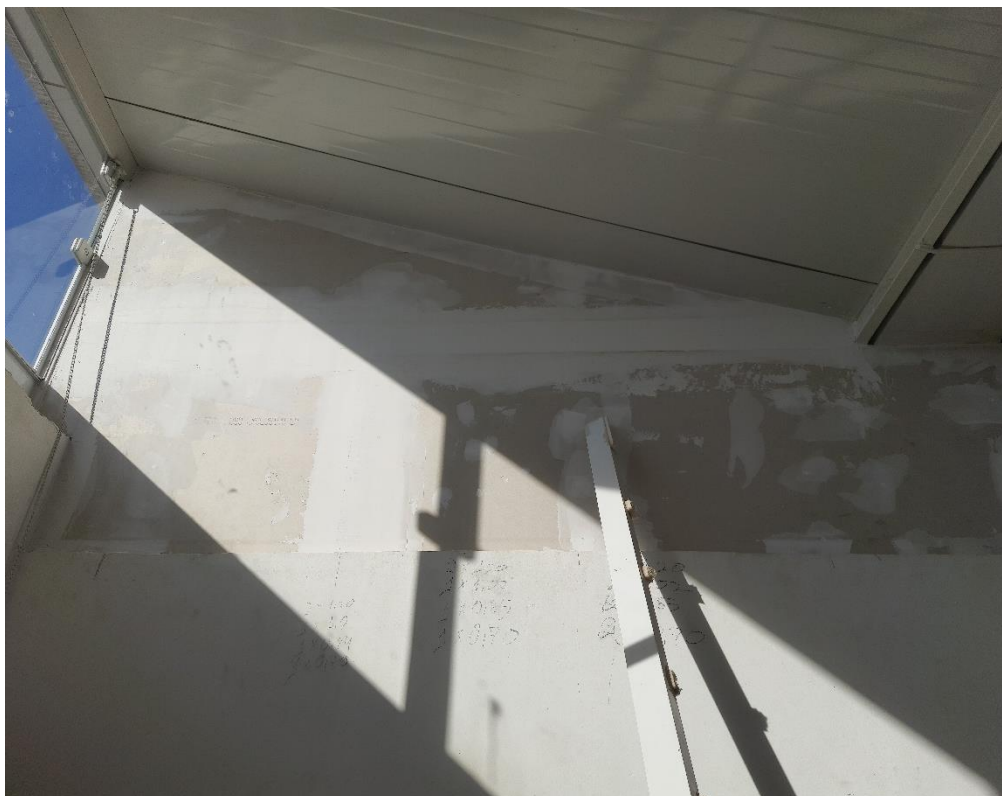
Figura 26 – Instalação de fechamento em gesso acartonado, 2º Pavimento.
