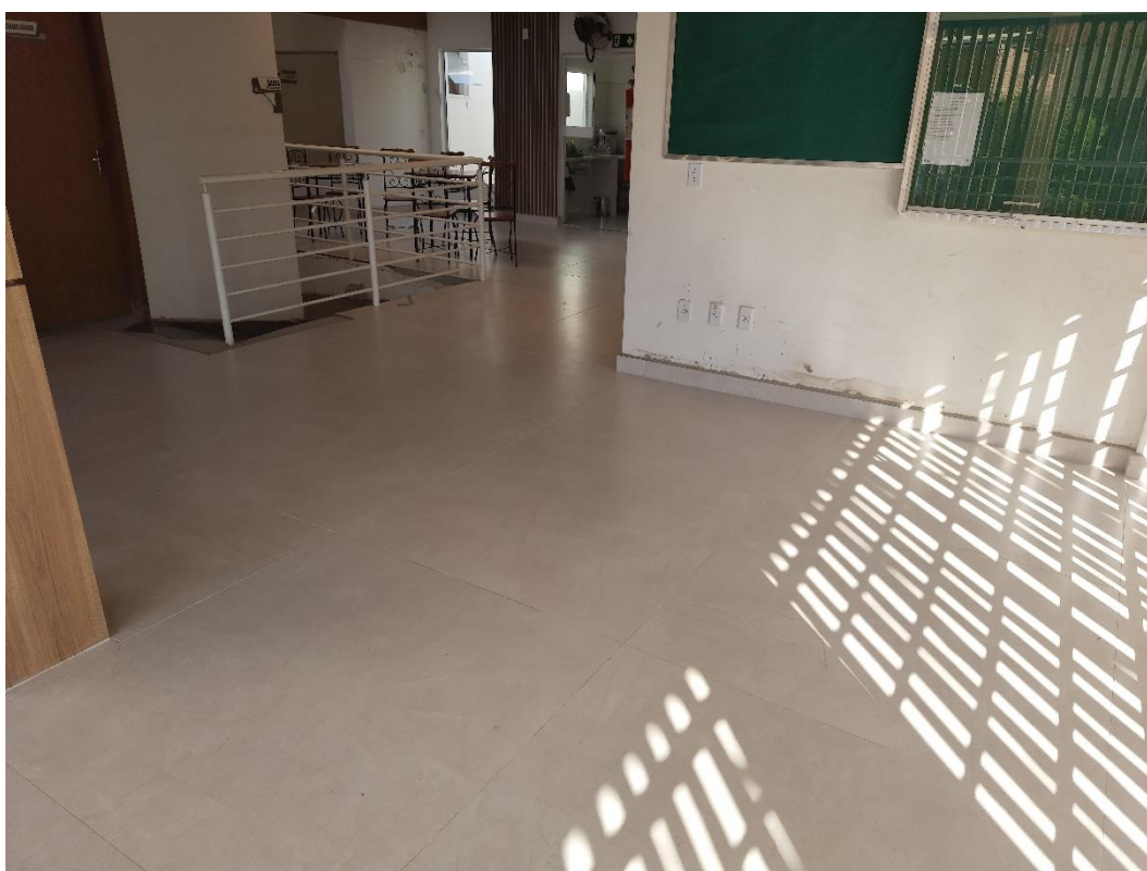
Figura 15 – Aplicação de porcelanato e rodapé no 2º Pavimento.
