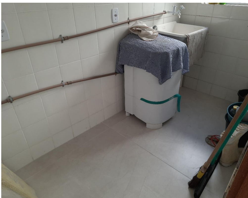
Figura 25 – Aplicação de porcelanato no 2º Pavimento.
