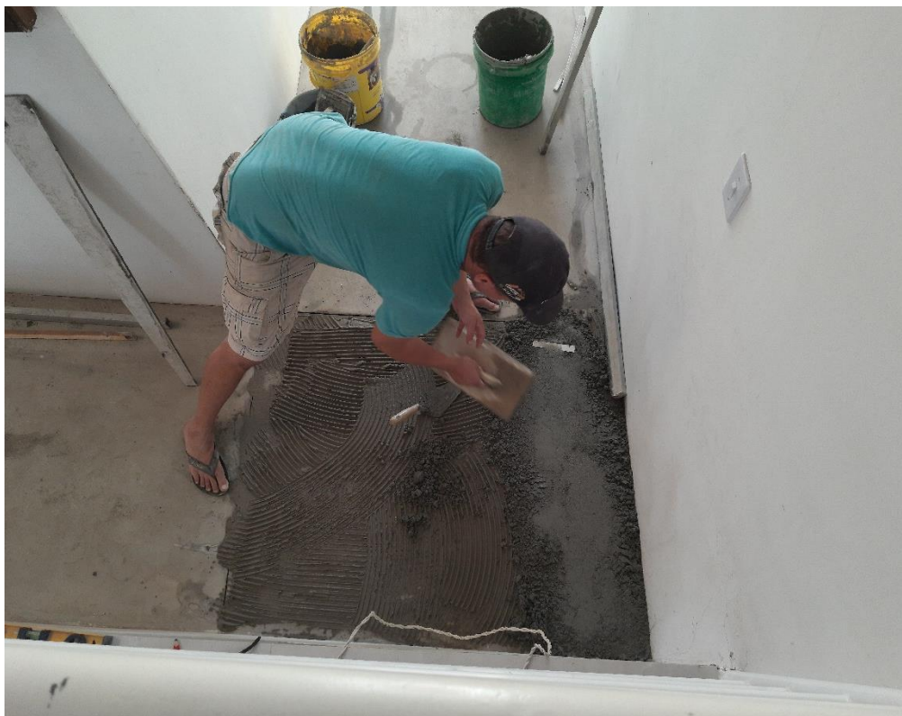
Figura 38 – Aplicação de porcelanato e rodapé no 2º Pavimento. Execução de contra-piso.
