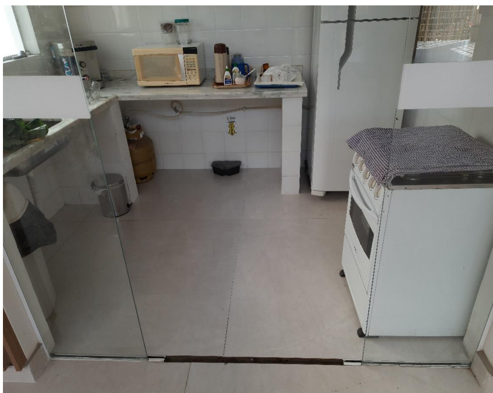
Figura 31 – Aplicação de porcelanato e rodapé no 2º Pavimento.
