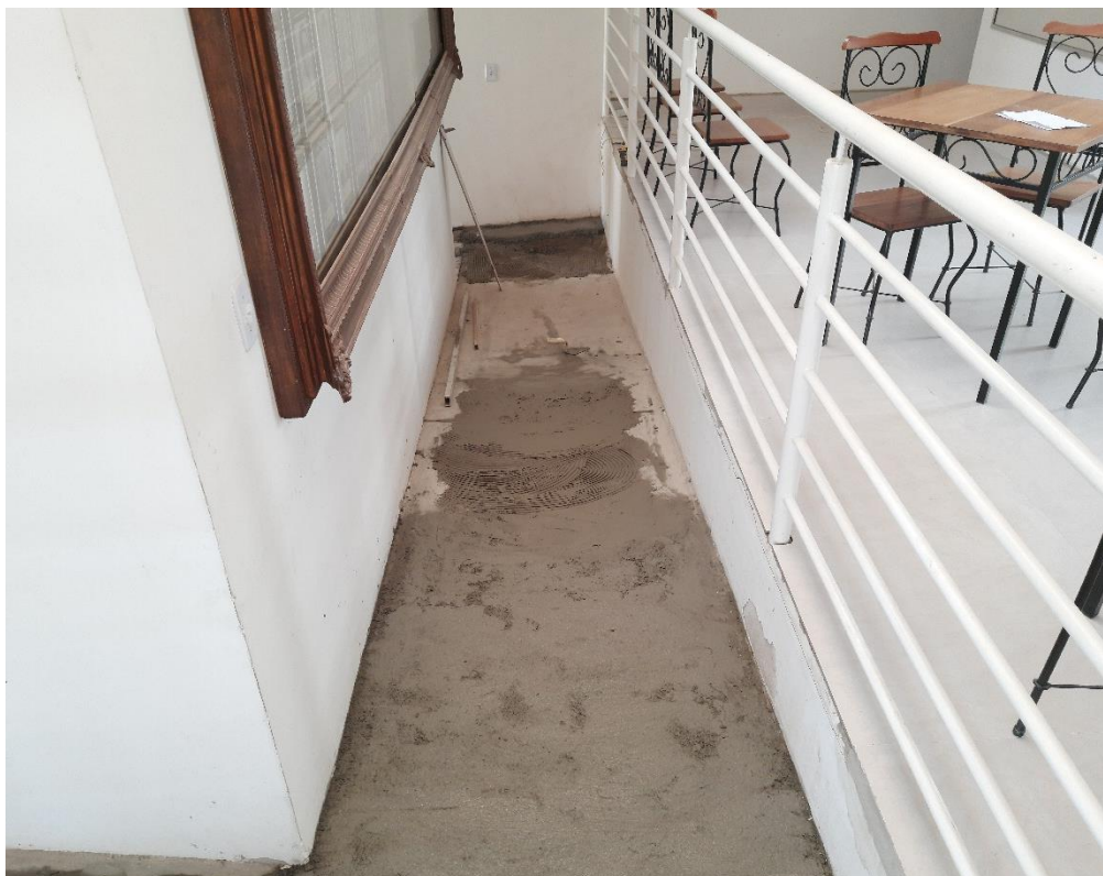
Figura 40 – Aplicação de porcelanato e rodapé no 2º Pavimento. Execução de contra-piso.
