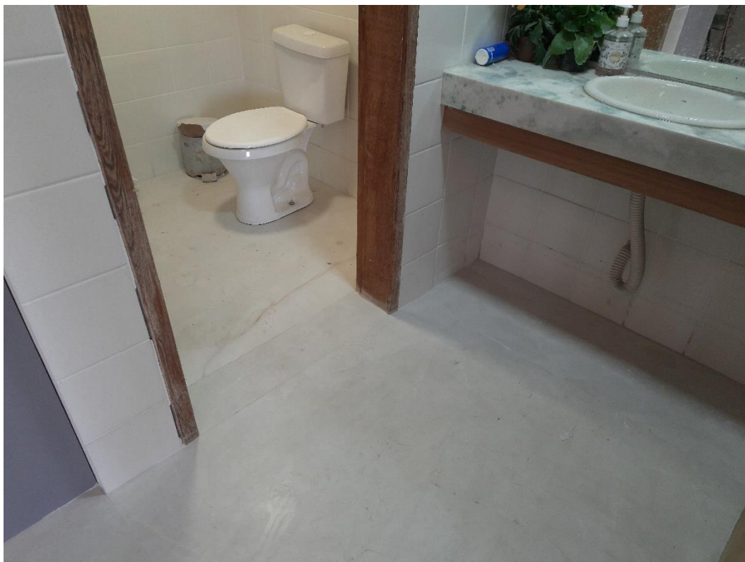
Figura 10 – Aplicação de porcelanato no 1º Pavimento.
