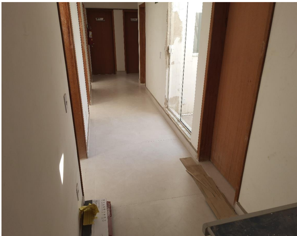
Figura 28 – Aplicação de porcelanato e rodapé no 2º Pavimento.
