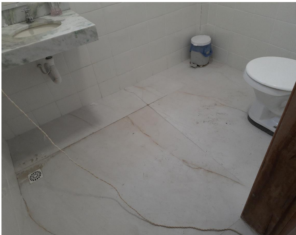
Figura 32 – Aplicação de porcelanato no 2º Pavimento.
