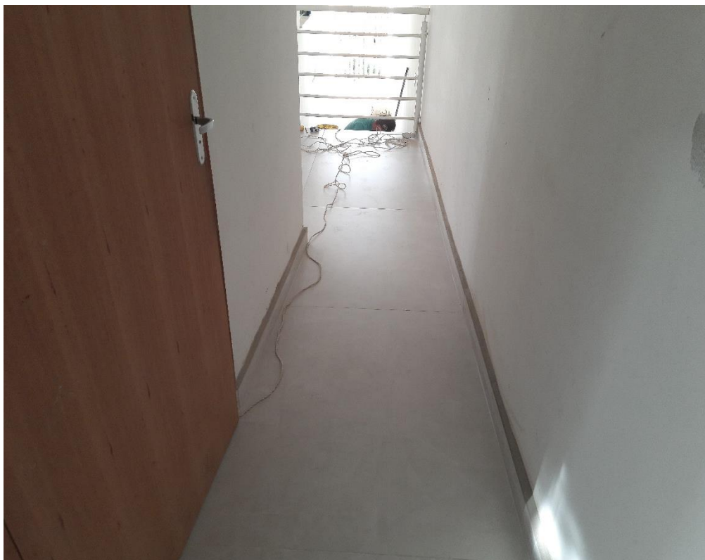
Figura 34 – Aplicação de porcelanato e rodapé no 2º Pavimento.
