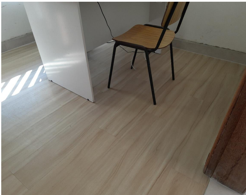
Figura 20 – Aplicação de rodapé. Piso vinílico já aplicado anteriormente. 2º Pavimento.
