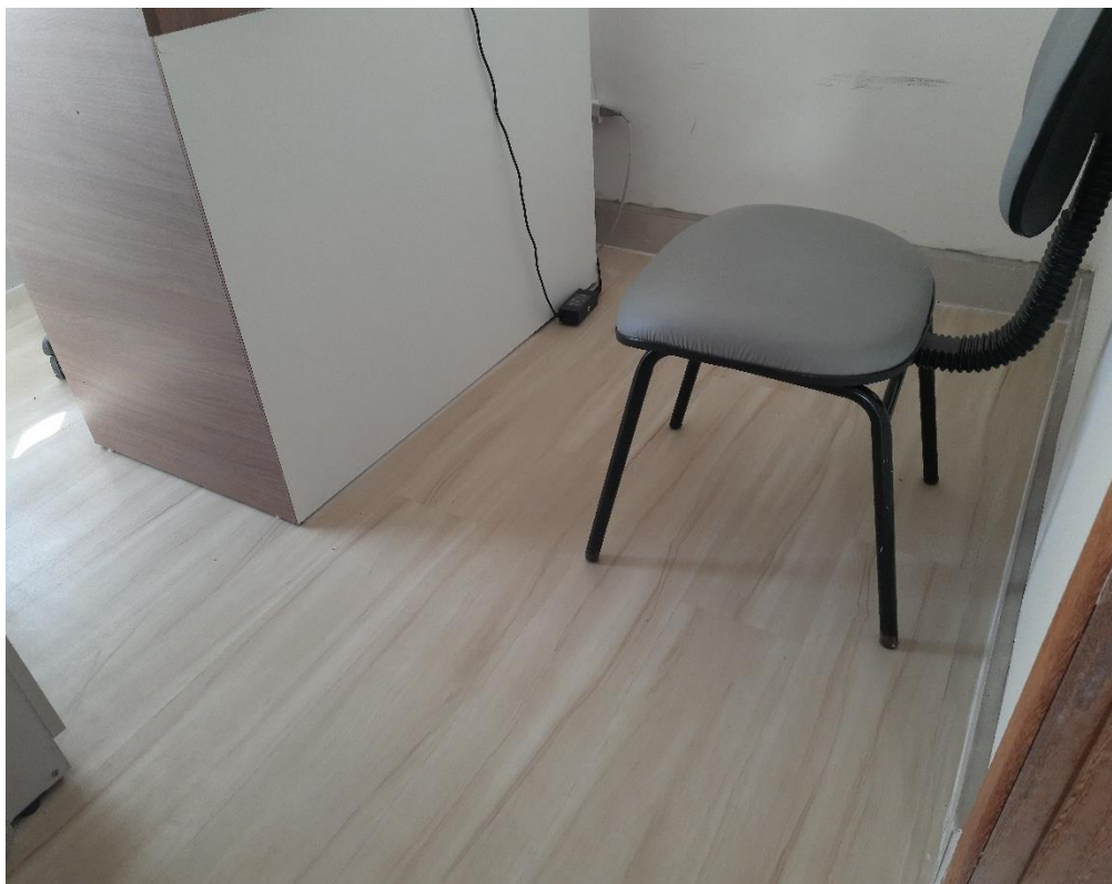
Figura 22 – Aplicação de rodapé. Piso vinílico já aplicado anteriormente. 2º Pavimento.
