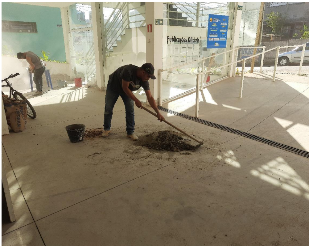
Figura 42 – Aplicação de porcelanato e rodapé na garagem do Pavimento Térreo.
