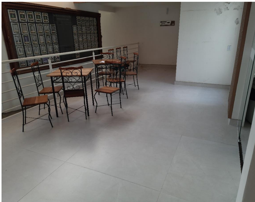
Figura 30 – Aplicação de porcelanato e rodapé no 2º Pavimento.
