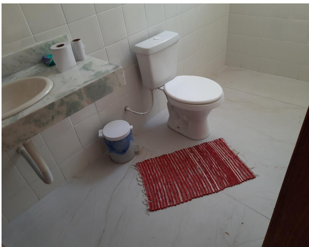
Figura 33 – Aplicação de porcelanato no 2º Pavimento.
