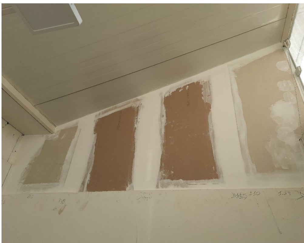
Figura 27 – Instalação de fechamento em gesso acartonado, 2º Pavimento.
