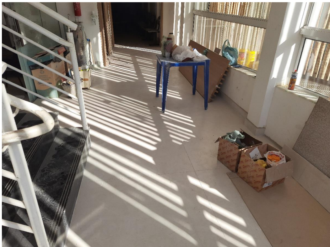
Figura 6 – Aplicação de porcelanato e rodapé no 1º Pavimento.
