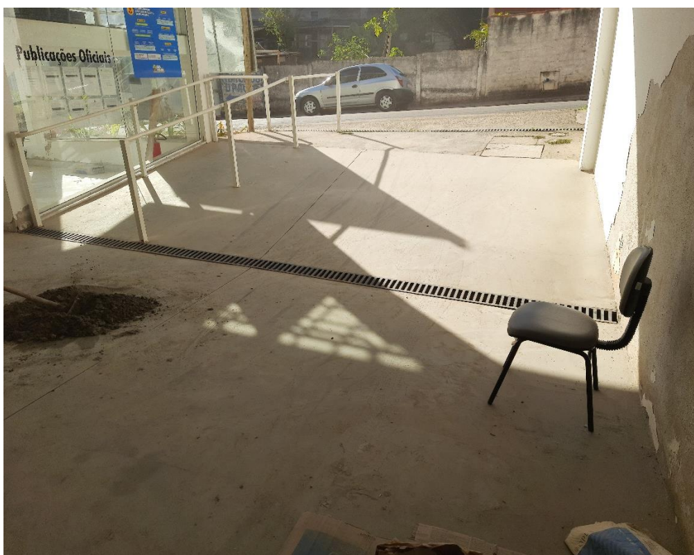
Figura 43 – Aplicação de porcelanato e rodapé na garagem do Pavimento Térreo.
