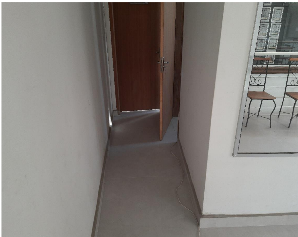
Figura 35 – Aplicação de porcelanato e rodapé no 2º Pavimento.
