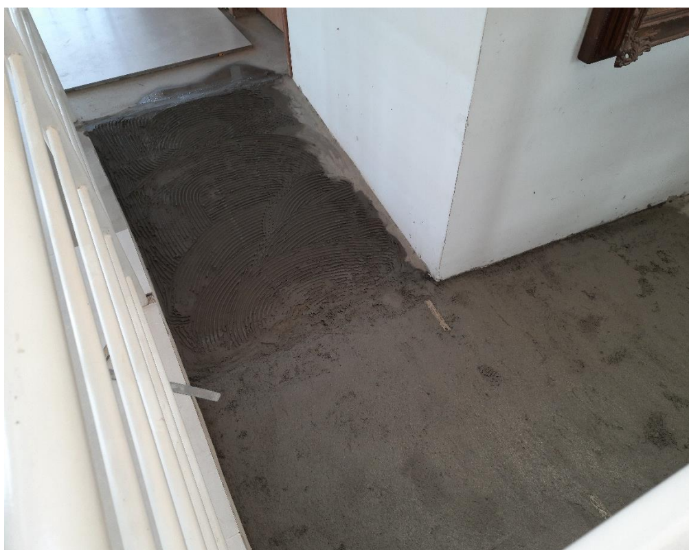
Figura 37 – Aplicação de porcelanato e rodapé no 2º Pavimento. Execução de contra-piso.
