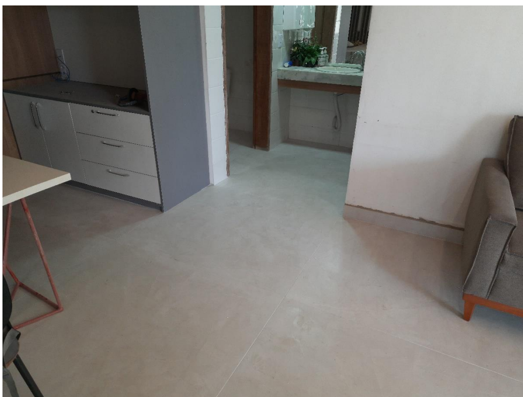
Figura 9 – Aplicação de porcelanato e rodapé no 1º Pavimento.
