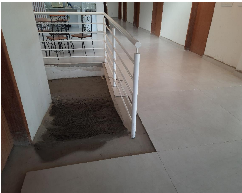
Figura 17 – Aplicação de porcelanato e rodapé no 2º Pavimento. Execução de contra-piso.
