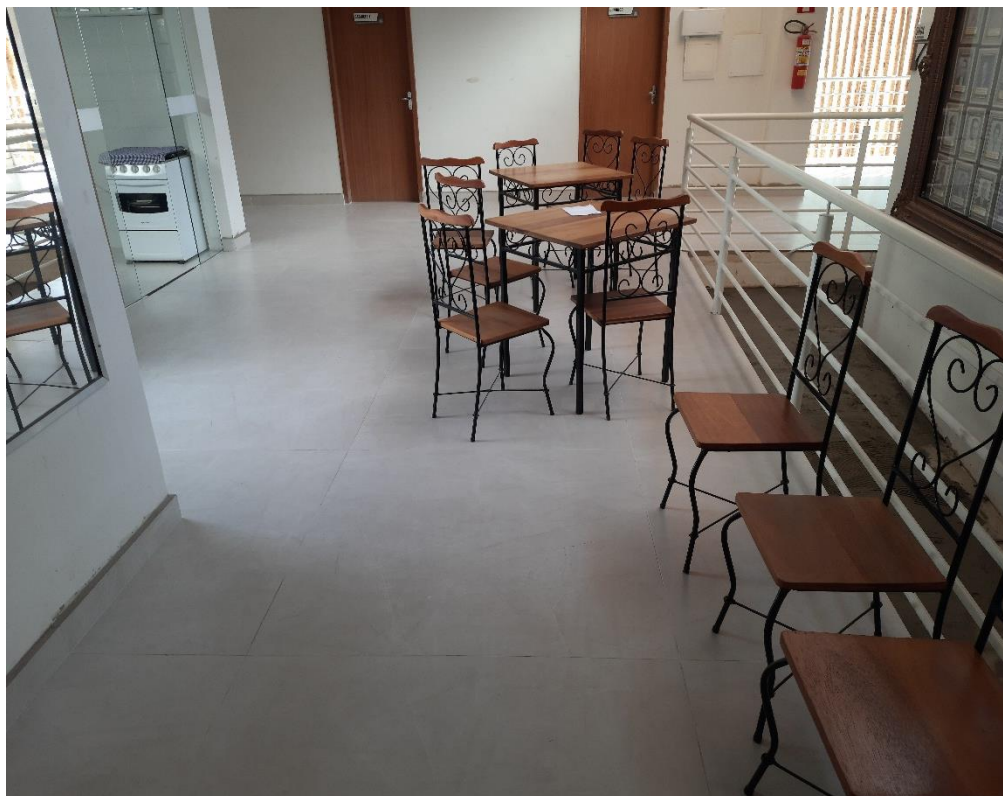
Figura 36 – Aplicação de porcelanato e rodapé no 2º Pavimento.
