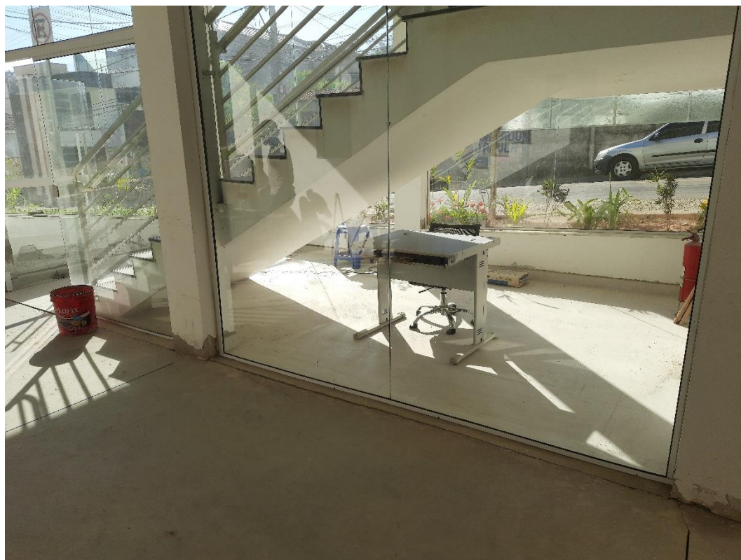
Figura 3 – Aplicação de porcelanato e rodapé no Hall do Pavimento Térreo.
