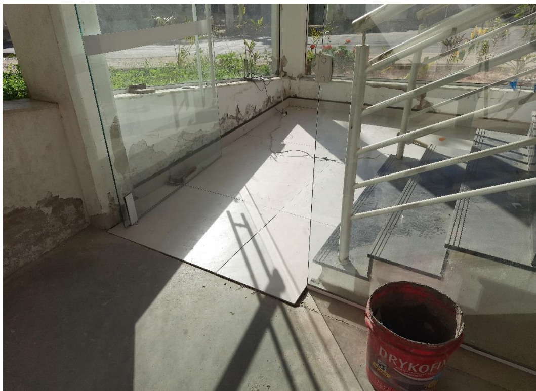
Figura 4 – Aplicação de porcelanato e rodapé no Hall do Pavimento Térreo.
