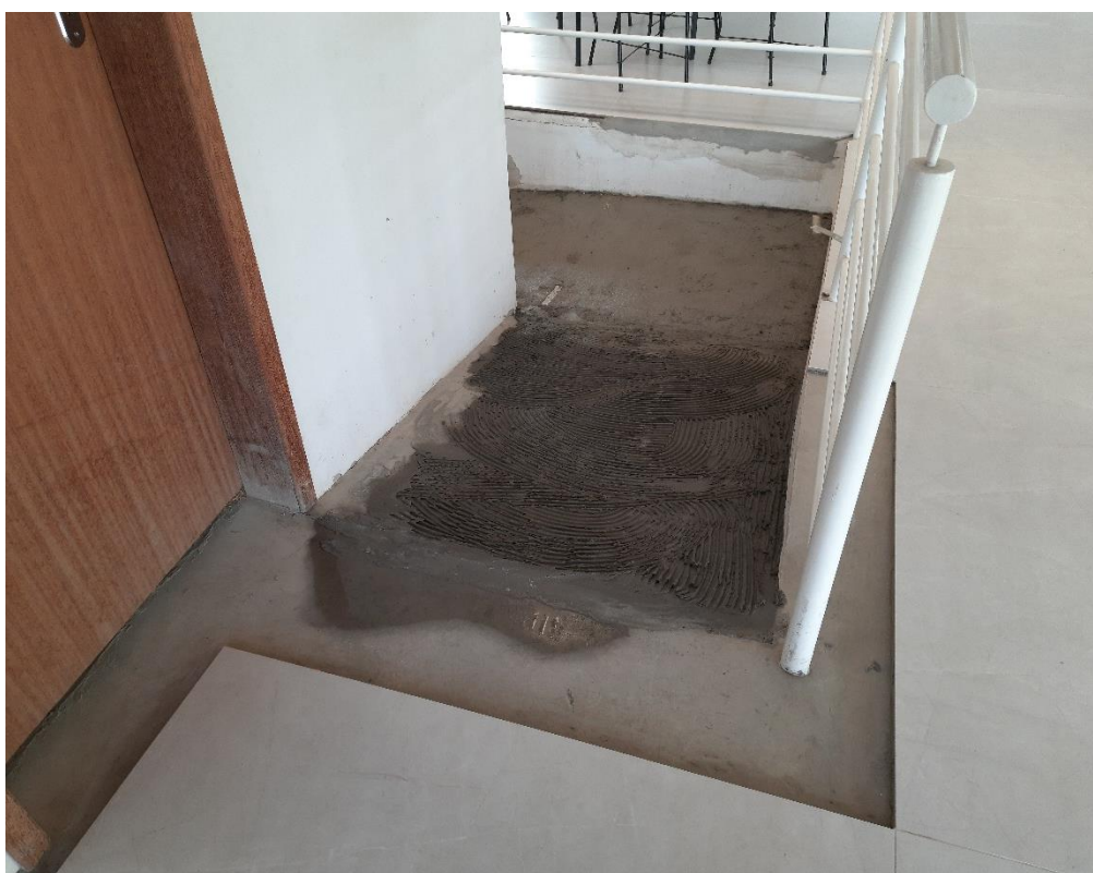
Figura 39 – Aplicação de porcelanato e rodapé no 2º Pavimento. Execução de contra-piso.
