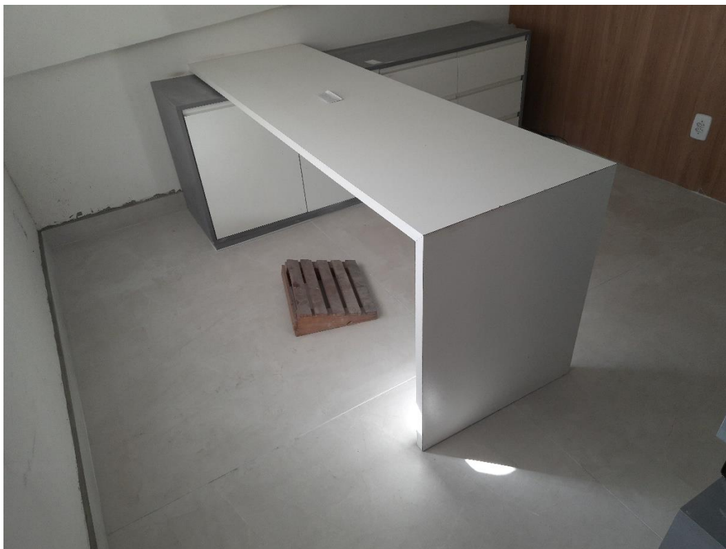
Figura 12 – Aplicação de porcelanato e rodapé no 1º Pavimento.
