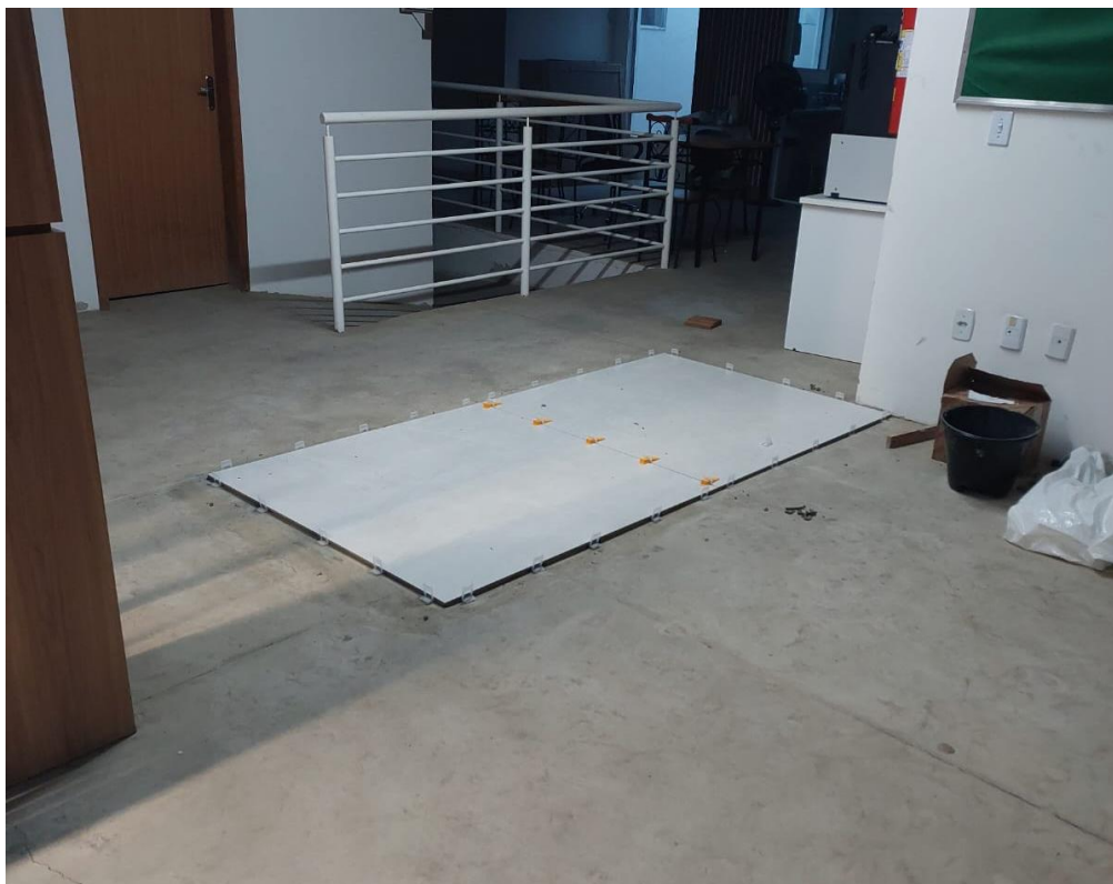
Figura 42 – Aplicação de piso em porcelanato no 2º pavimento.
