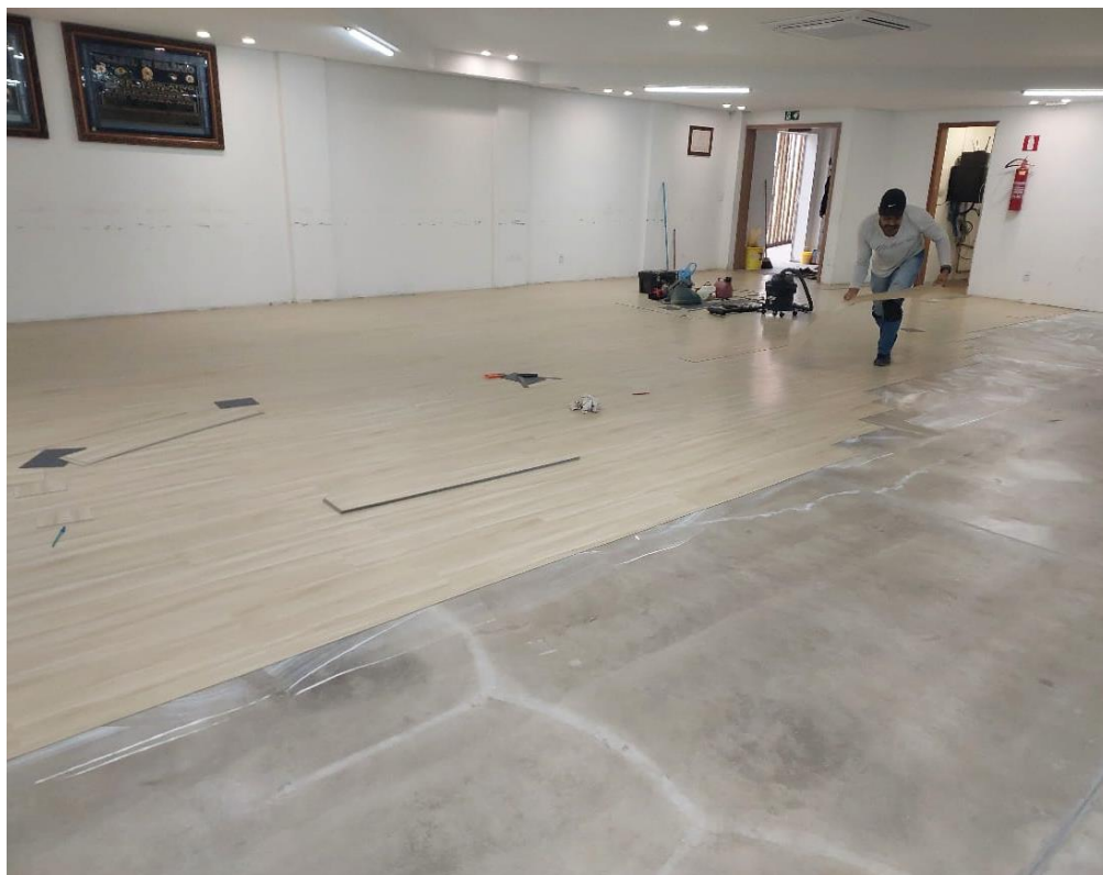
Figura 20 – Aplicação do piso vinílico no Plenário.
