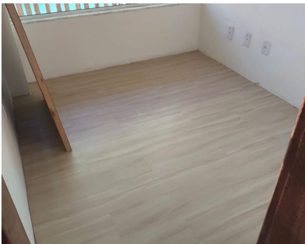
Figura 29 – Retirada de porta, instalação de piso vinílico e reinstalação de porta.
