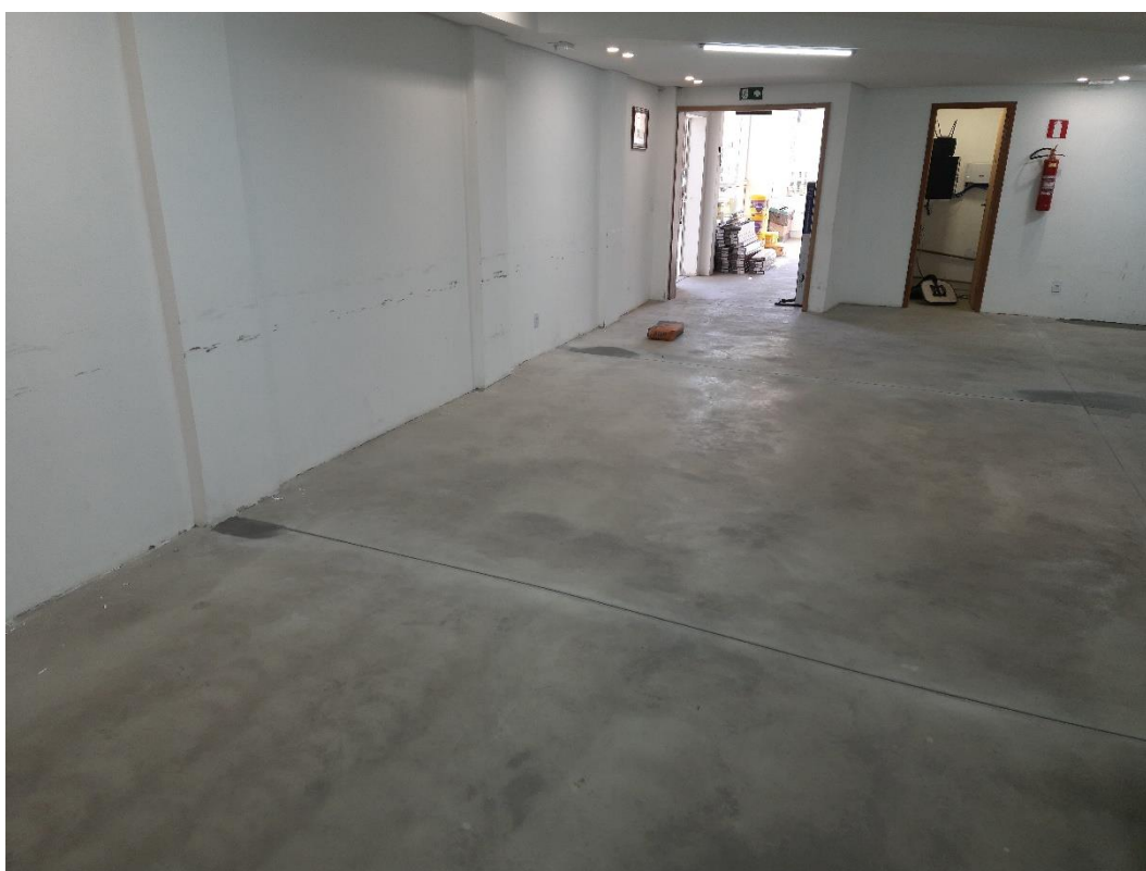
Figura 13 – Calafetação e reparos no piso sendo executados, no Plenário.
