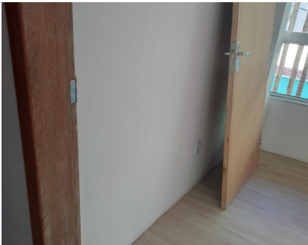
Figura 28 – Retirada de porta, instalação de piso vinílico e reinstalação de porta.
