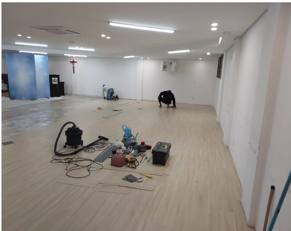
Figura 19 – Aplicação do piso vinílico no Plenário.
