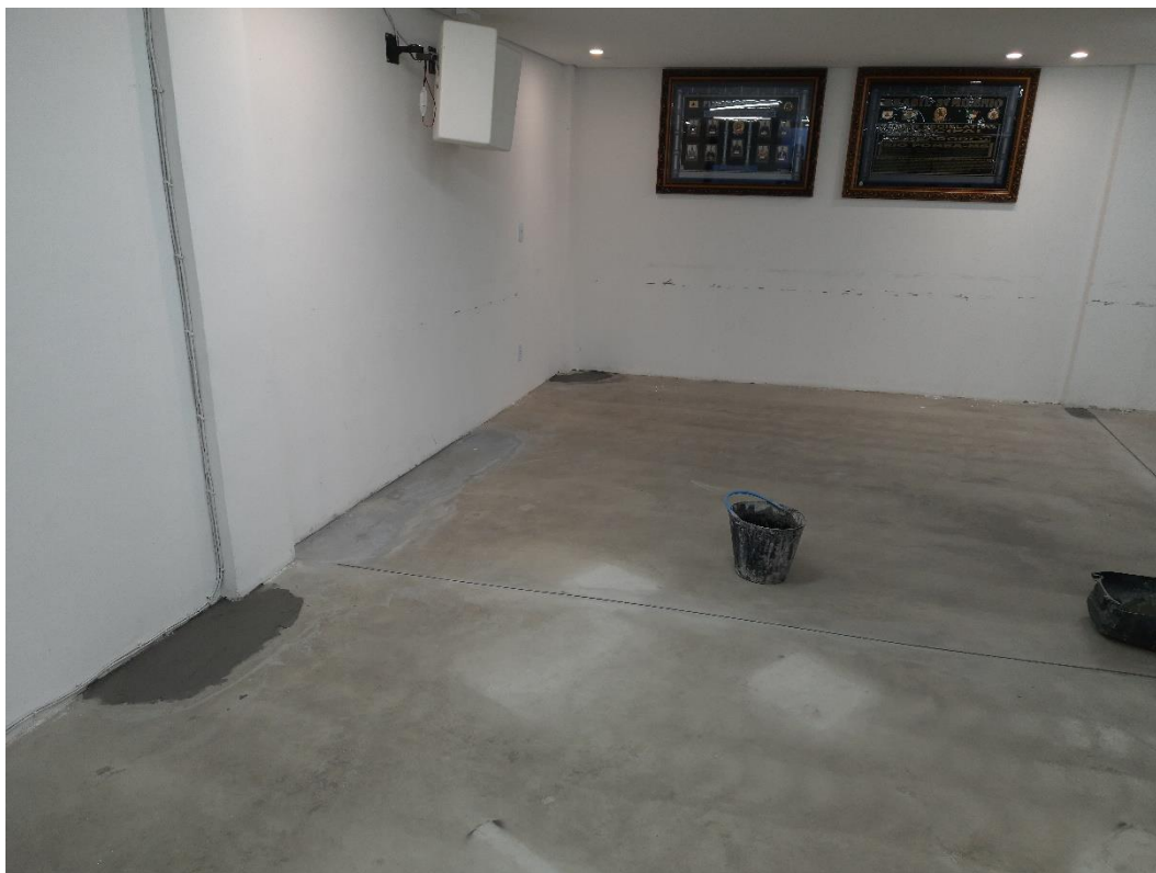
Figura 12 – Calafetação e reparos no piso sendo executados, no Plenário.
