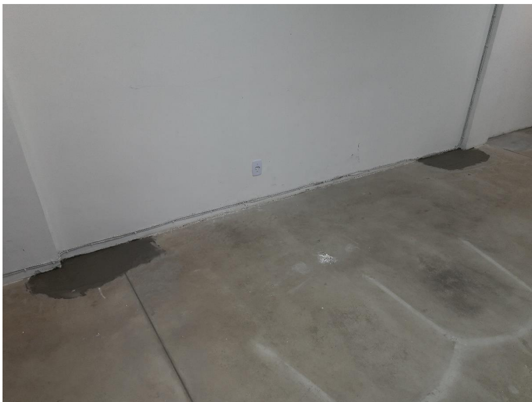
Figura 11 – Calafetação e reparos no piso sendo executados, no Plenário.
