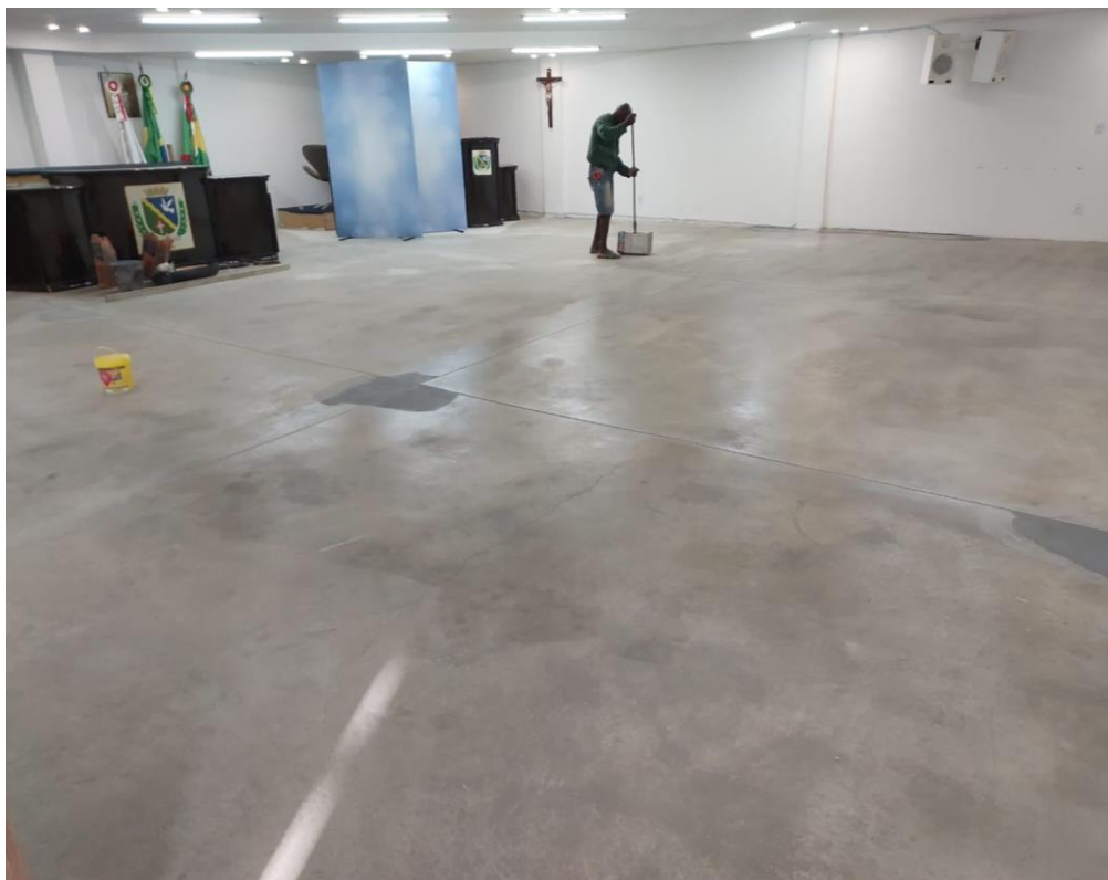
Figura 18 – Aplicação de prime, para posterior aplicação de piso vinílico.
