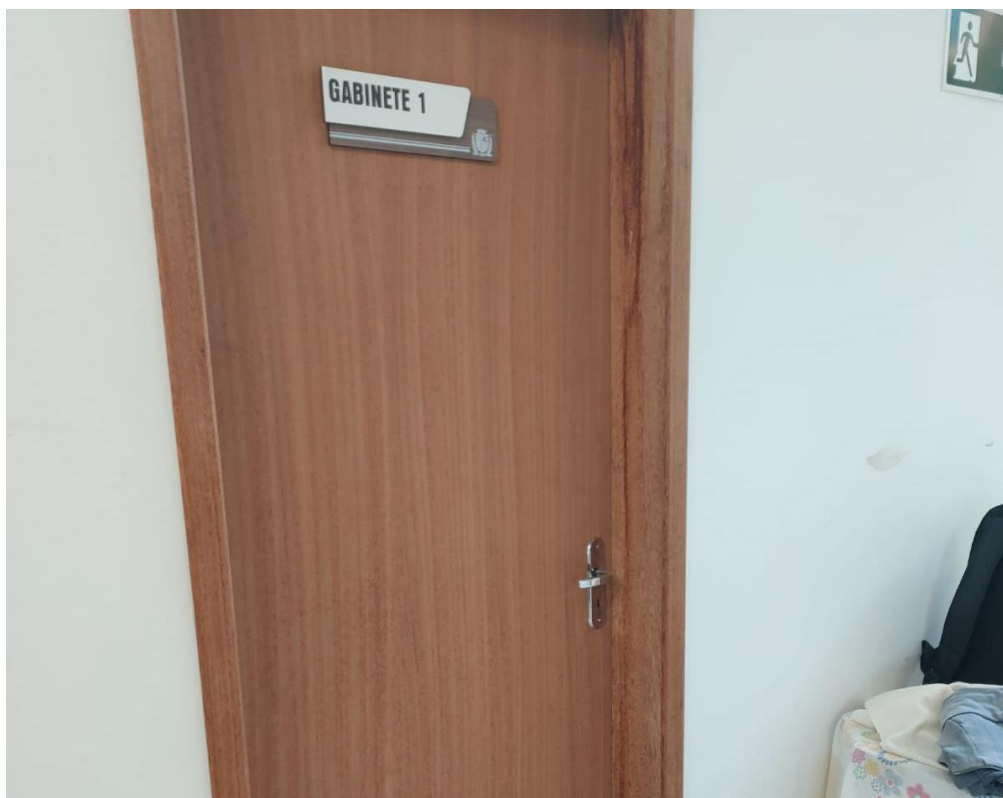
Figura 32 – Salas do 2º pavimento com piso finalizado e com mobiliário montado e reinstalado.
