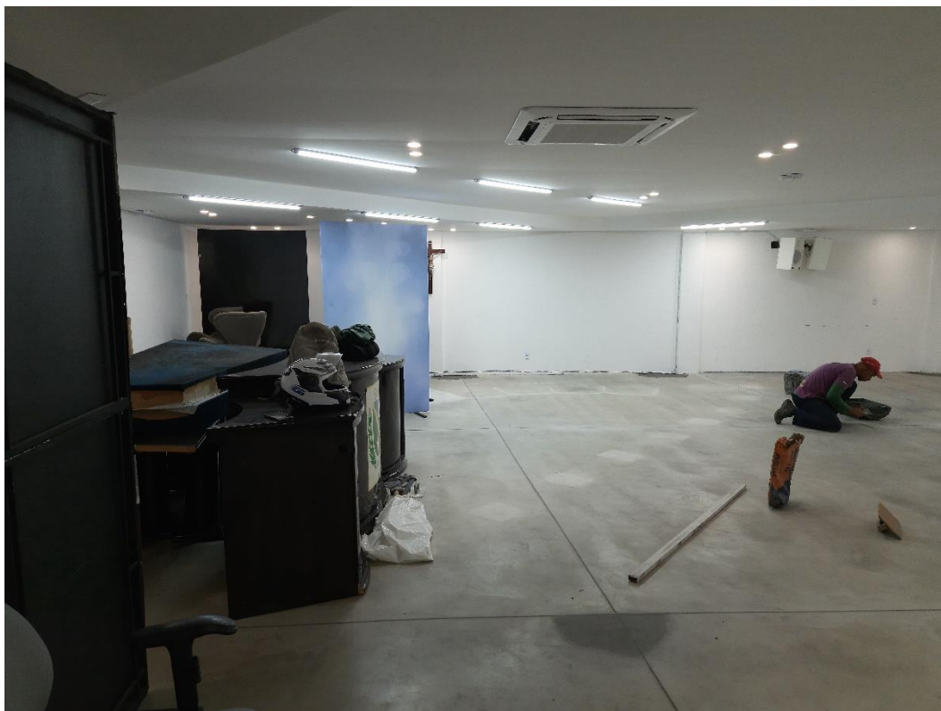
Figura 10 – Calafetação e reparos no piso sendo executados, no Plenário.
