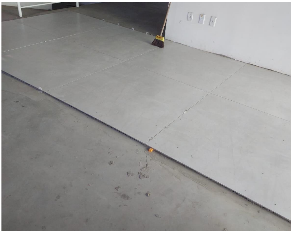
Figura 43 – Aplicação de piso em porcelanato no 2º pavimento.
