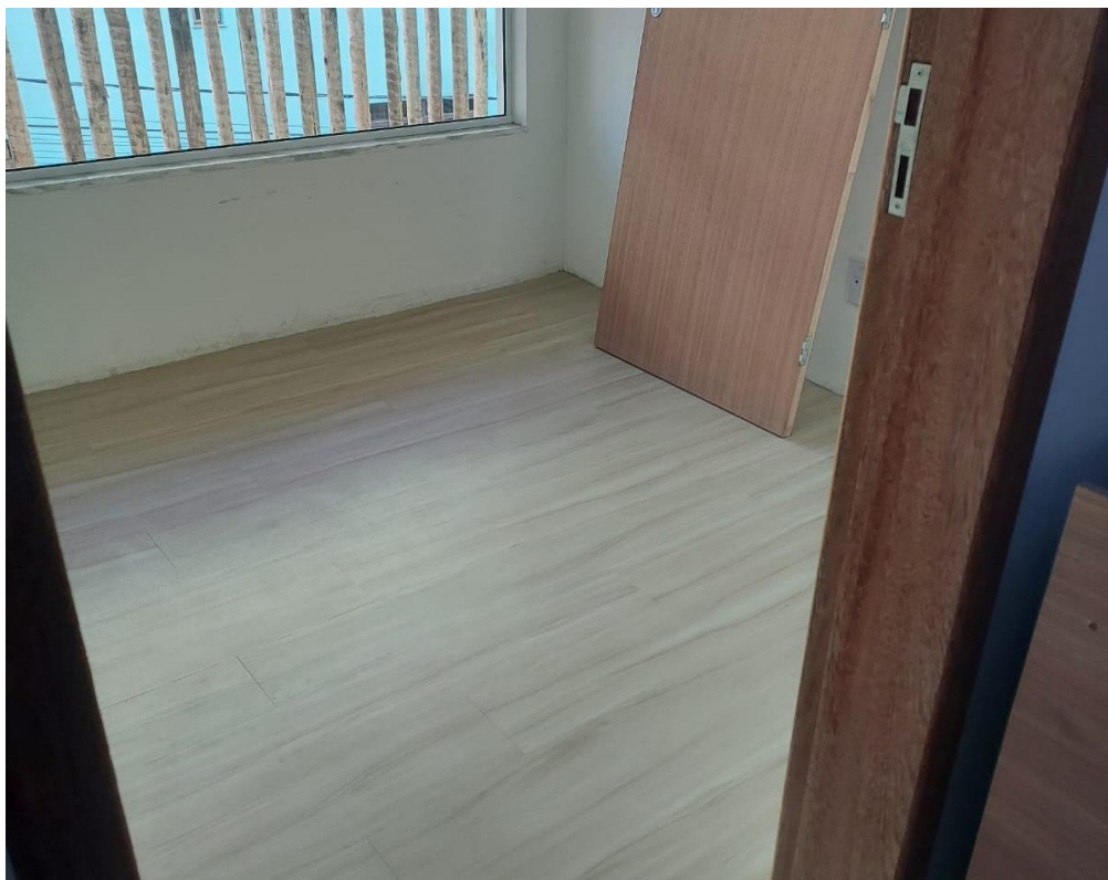
Figura 30 – Retirada de porta, instalação de piso vinílico e reinstalação de porta.
