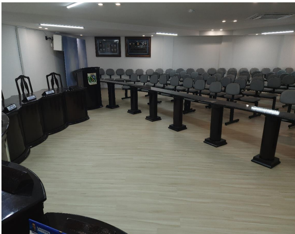
Figura 25 – Piso vinílico finalizado, com mobiliário montado e reinstalado.
