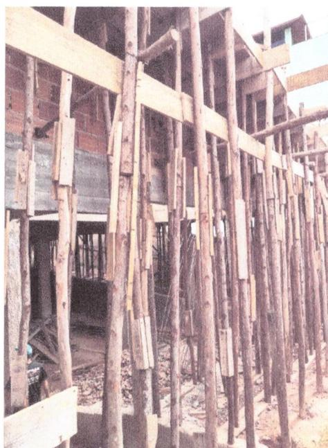
Foto 03 – Armação laje inclinada e vigamento teto 1º pavimento
